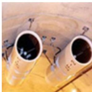
La ventilation vise à maîtriser les niveaux de pollution en maintenant une bonne visibilité et, en cas d'incendie, en sécurisant les voies d'évacuation et l'accès des équipes de secours, et à limiter la dégradation de l'ouvrage. Il existe différents systèmes de ventilation. Le plus basique est la ventilation naturelle obtenue par la différence de pression aux extrémités de tunnel. Les
