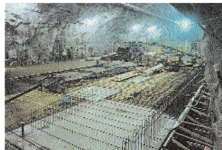
La couverture du terrain est composée de couches de sable meuble compactées par vibration. Les explosions ont, de ce fait, exigé de grandes précautions. Le fond de la chambre se trouve à environ 7 m au-dessous du niveau d'eau du Lac Mälaren, ce qui a nécessité l'étanchéification de la totalité du terrain autour de l'excavation.
