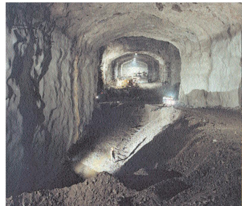
25 mm de diamètre. Au total, 55.000 boulons ont été mis en place. Le béton projeté a été utilisé pour le plafond et les parois sur une surface totale de 199.000 m<sup>2</sup>, ce qui a nécessité un volume total de 19.000 m<sup>3</sup> de béton projeté, dont 7.000 m<sup>3</sup> armés de fibres. Dans la zone faible, on
