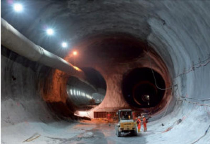
La excavación convencional se puede definir como la construcción de cavidades subterráneas de forma arbitraria utilizando un proceso cíclico que consta de los siguientes pasos:
