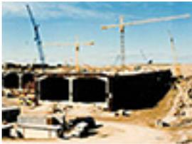
Los elementos del túnel se construyen en seco, por ejemplo, en una dársena de prefabricación, un astillero, una plataforma elevadora para buques o una fábrica.
