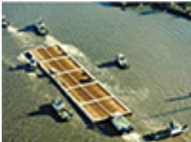
Cada elemento del túnel se traslada hasta su ubicación normalmente por medios flotantes, en ocasiones en una barcaza o con la ayuda de grúas.
