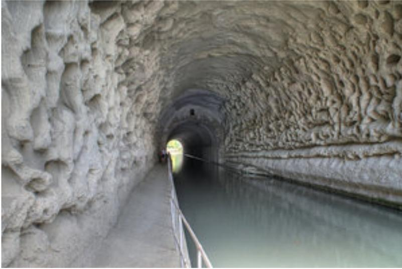
Los canales de navegación tienen que ser prácticamente horizontales, de modo que cuando aparece algún accidente topográfico hay que construir un túnel.
