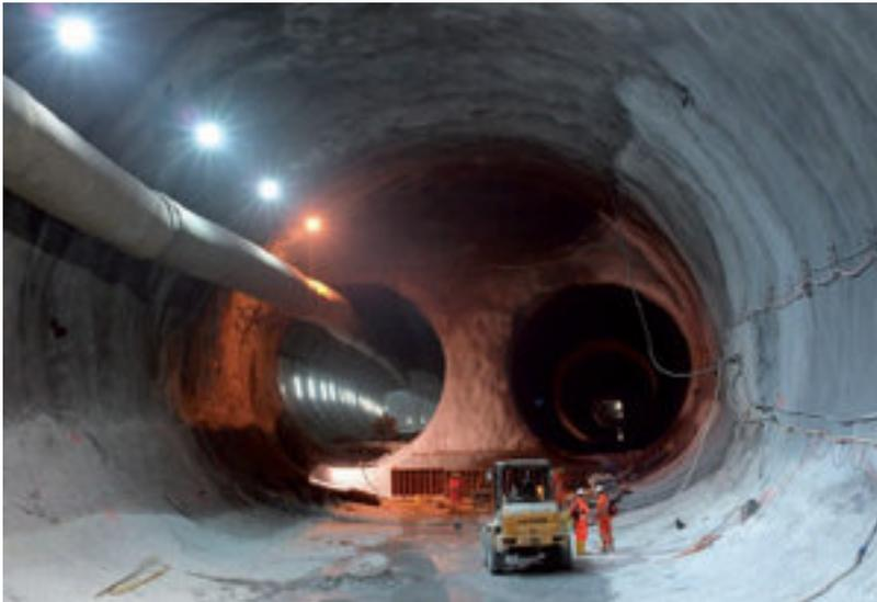
Le creusement conventionnel peut être défini comme la construction d'ouvertures souterraines d'une quelconque forme, suivant un processus cyclique de construction comprenant les étapes suivantes:
