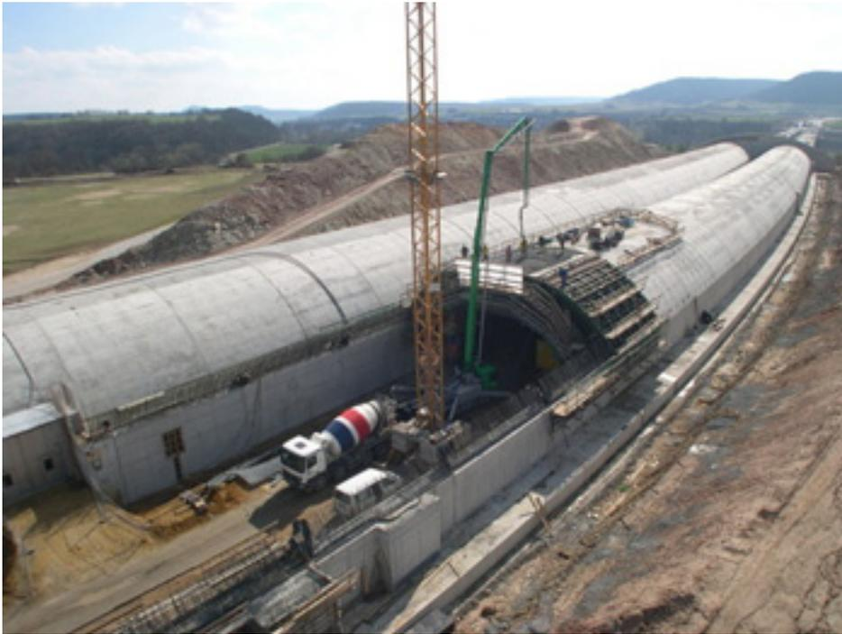
Selon l'ordre de construction, le système de tranchée couverte peut être réalisé suivant des méthodes d'excavation « directe », « inverse » ou « door frame ».
