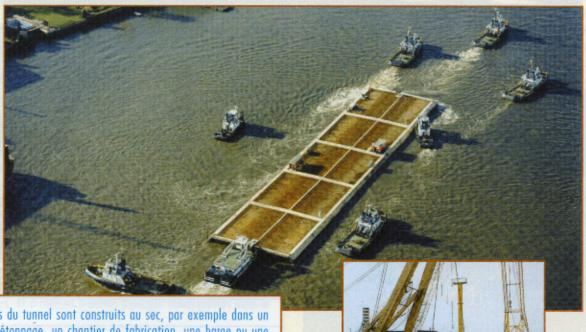
Les caissons du tunnel sont construits au sec, par exemple dans un bassin de bétonnage, un chantier de fabrication, une barge ou une usine. Les extrémités du caisson sont alors provisoirement étanchéisés au moyen de cloisons étanches.
