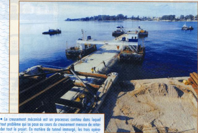
Le creusement mécanisé est un processus continu dans lequel tout problème qui se pose au cours du creusement menace de retarder tout le projet. En matière de tunnel immergé, les trois opérations qui ont lieu - dragage, construction des caissons et installation de ceux-ci - peuvent avoir cours simultanément ce qui réduit considérablement les risques du programme. En partie pour cette raison, un tunnel immergé prend moins de temps à construire que le tunnel foré équivalent.
