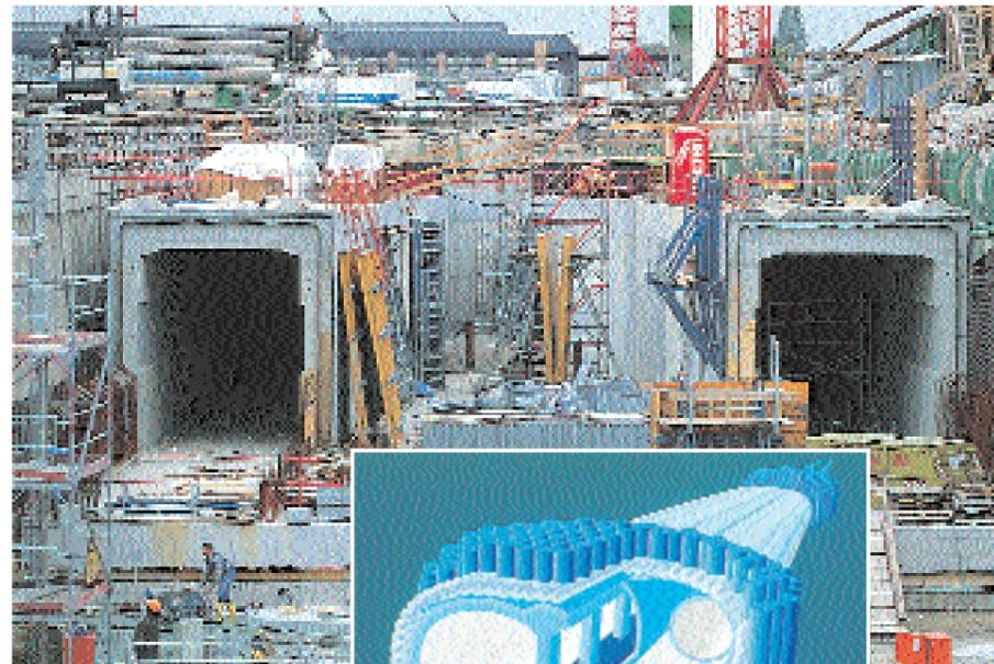
Porte de Brandebourg et de Spreeinsel seront excavées en souterrain après congélation des sols. Les aiguillages nécessaires au niveau de la rue Unter den Linden seront également construits en souterrain. La construction des stations Unter den Linden (U5/U6) et Berliner Rathaus sera pour l'essentiel réalisée en tranchée ouverte en raison du niveau des voies ferrées actuellement en place. Pour la remise en
